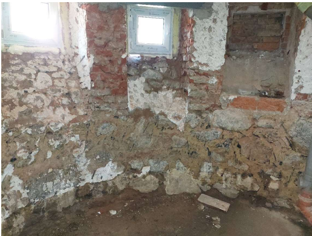
Obr. 6: Suterénní smíšené zdivo v místě obloukového nároží
