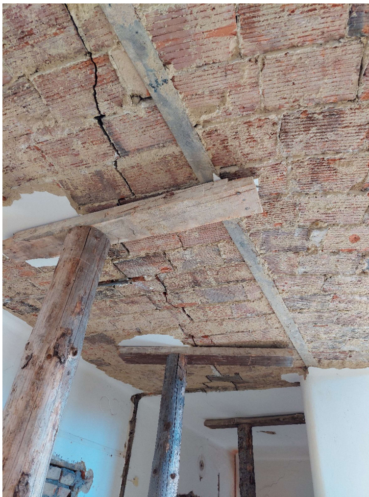
Obr. 11: Porušená cihelná deska schodišťové podesty – patrná je příčná trhлина a deformace desky. Provizorní podepření je provedeno nedostatečně.
