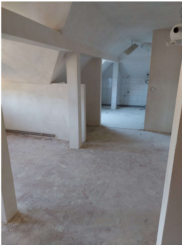
Obr. 8: Téměř hotová sádrokartonová půdní vestavba, obloženy jsou prvky krovu i podhledy
