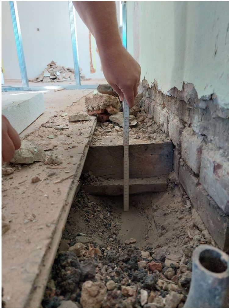
Obr. 4: Dřevěný trámový strop
