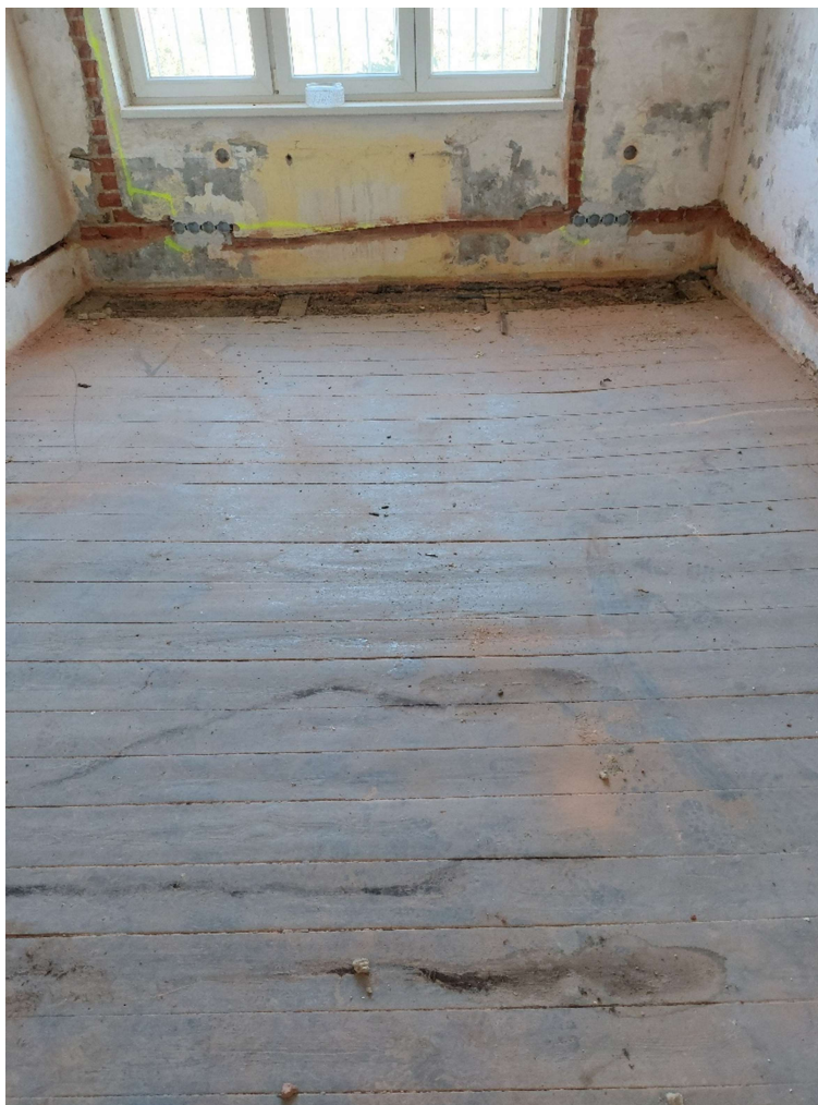
Obr. 13: Stávající pronesený dřevěný strop, na kterém je na první pohled patrné prohnutí. Strop má být dále zatížen novými podlahovými vrstvami.
