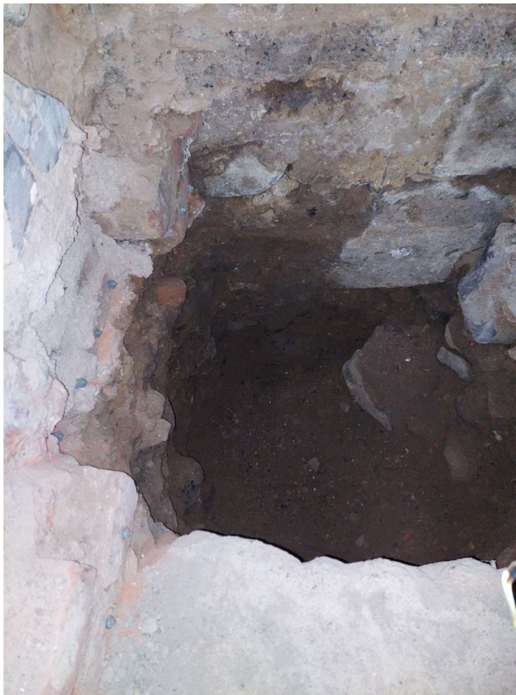
Obr. 7: Výkop v suterénu odhalující úroveň základové spáry
