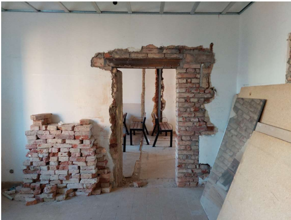
Obr. 12: Jak je vidno, přetěžování podlah skladováním těžkého materiálu je stálý nešvar. Takto navrstvená kupa cihel představuje reálné nebezpečí provalení stropu!
