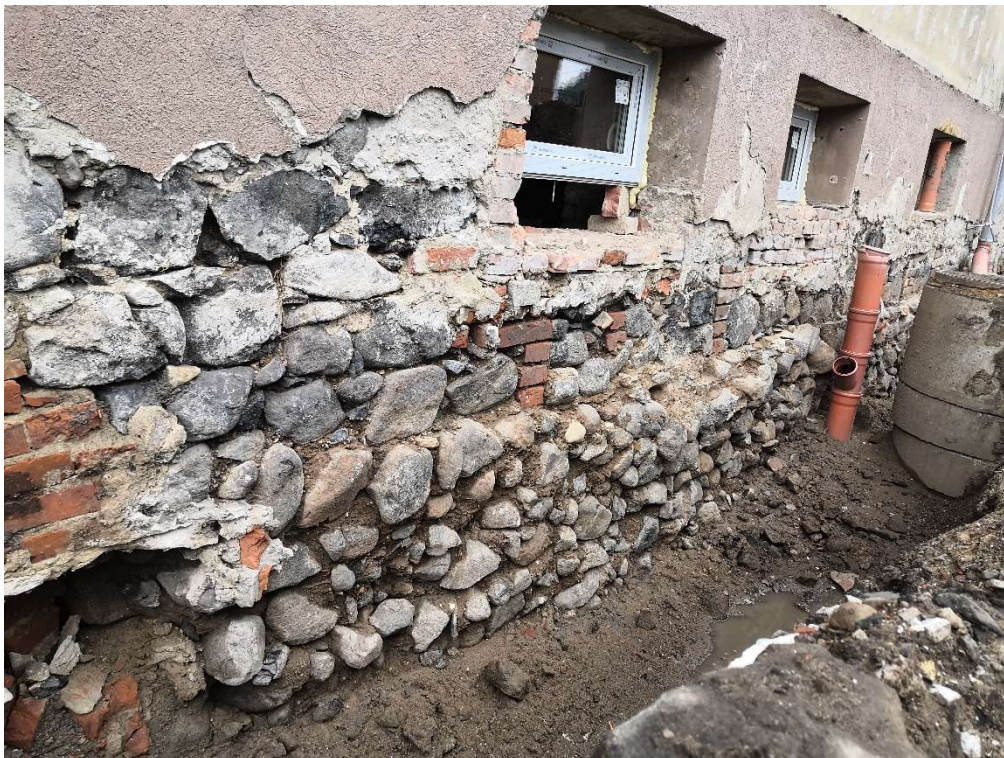
Obr. 14: Obnažená západní suterénní stěna – vydrolená malta, rozrušené zdivo, vypadlé kusy staviva. Kvalita zdiva je patrná na první pohled...
