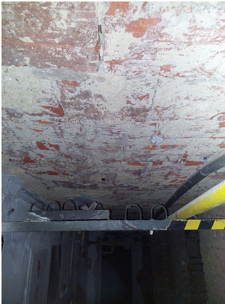
Obr. 10: Deformovaná cihelná stropní deska nad suterénem v chodbě – patrné je prohnutí desky směrem dolů a otevírající se trhлина ve spáře mezi cihlami
