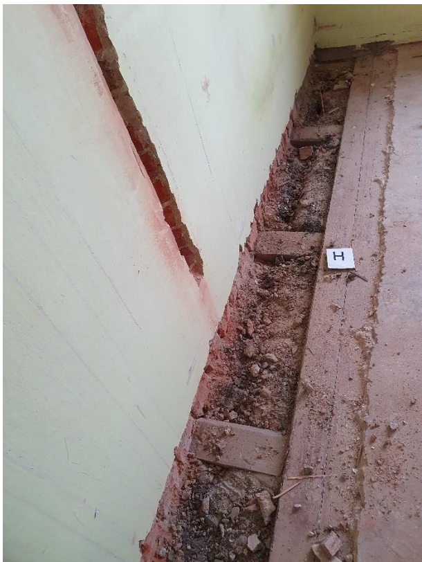
Dokumentace sond podlah místnosti 3.10 ve 3.NP: vlevo severní stěna, vpravo vnitřní stěna
