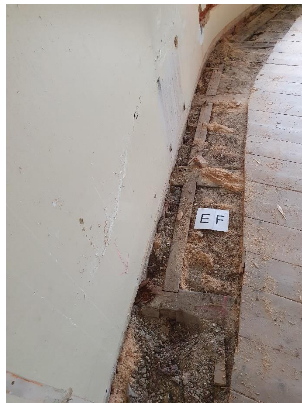
Dole: Dokumentace sond podlah 4.NP. Vlevo pohled EE, vpravo EF
