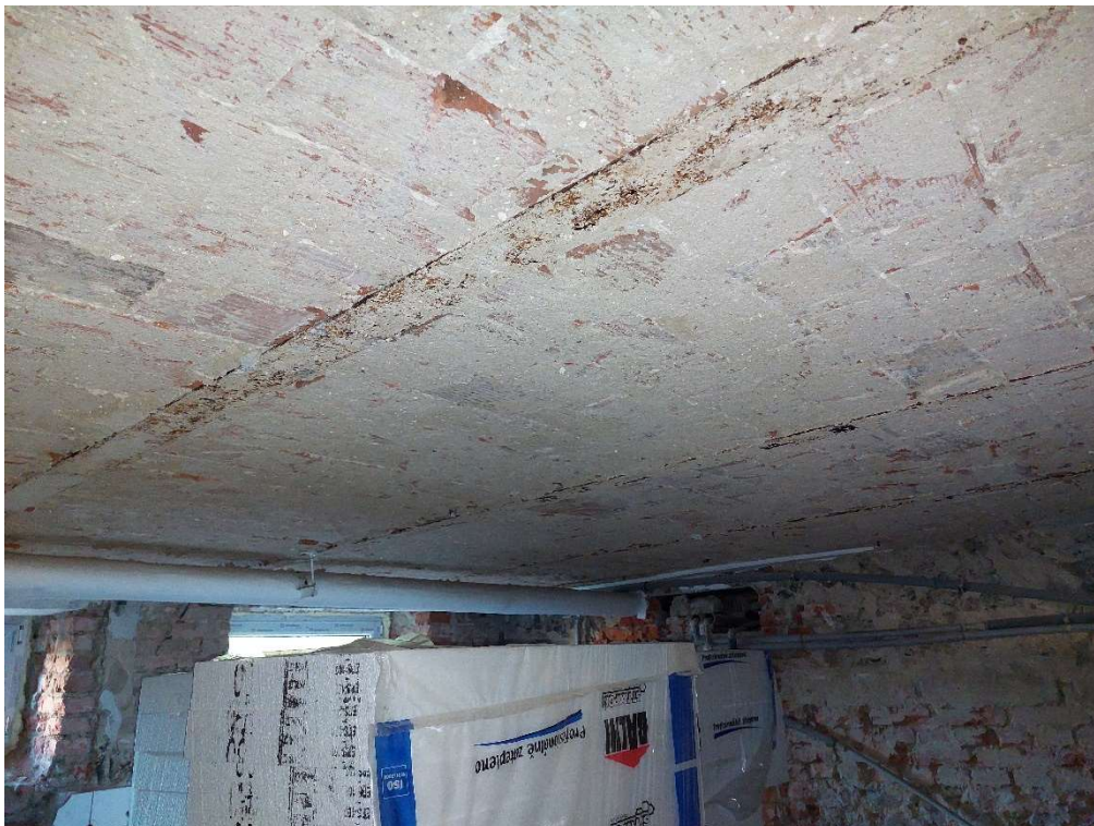
Obr. 5: Spodní líc stropu s ocelovými stropnicemi a cihelnými deskami
