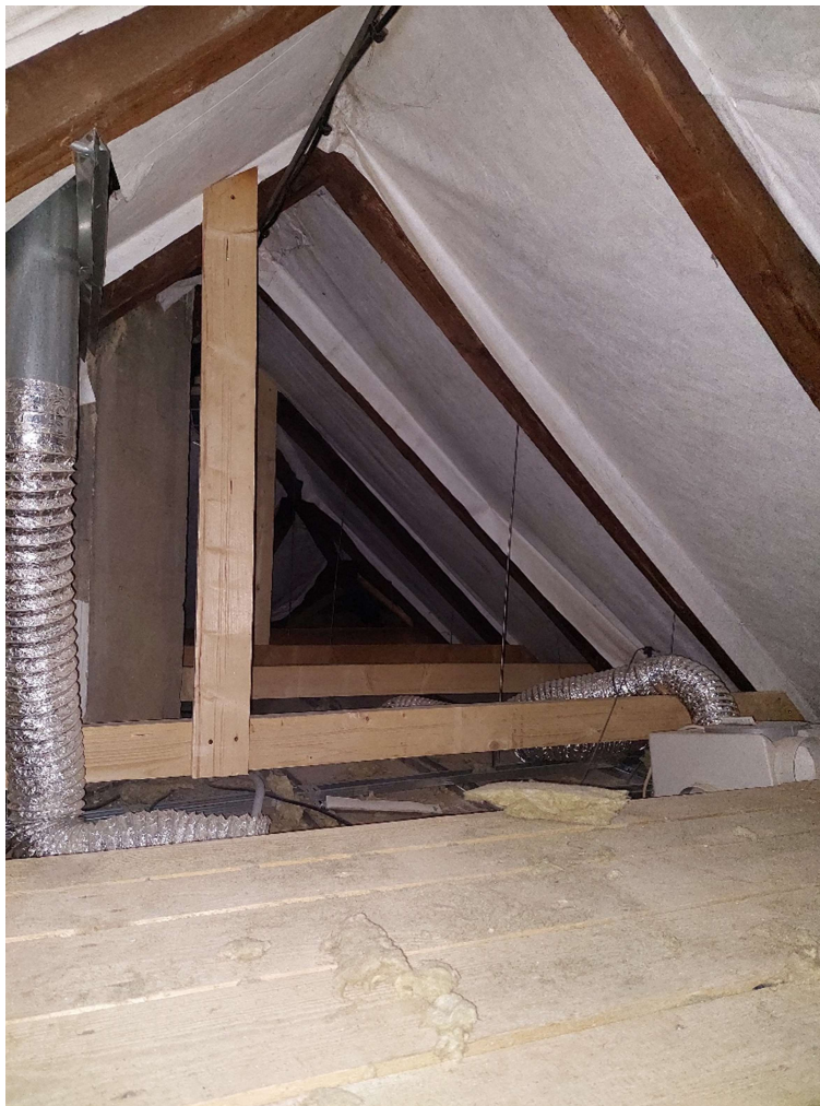
Obr. 9: Pohled do hřebene střechy nad půdní vestavbou – za povšimnutí stojí naprosto neúčinně provedená pojistná hydroizolace přisponkovaná z boku ke krokvím nespojitě, v každém poli zvlášť...
