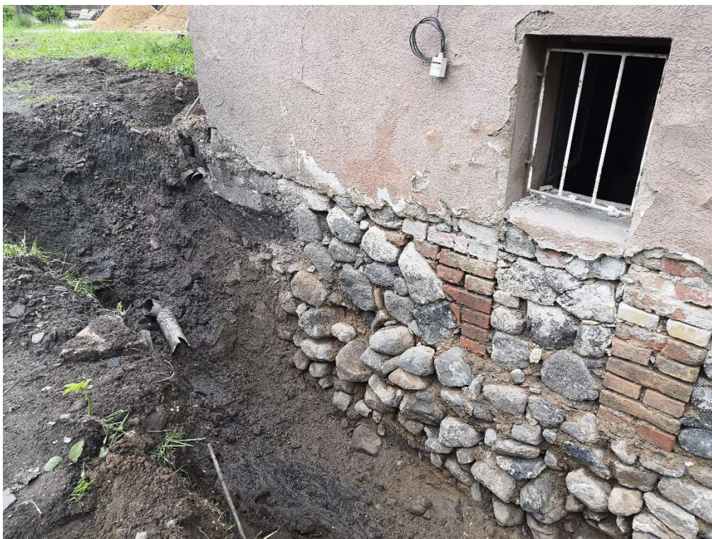
Obr. 16: Chybějící zdivo suterénní stěny na severozápadním rohu.
