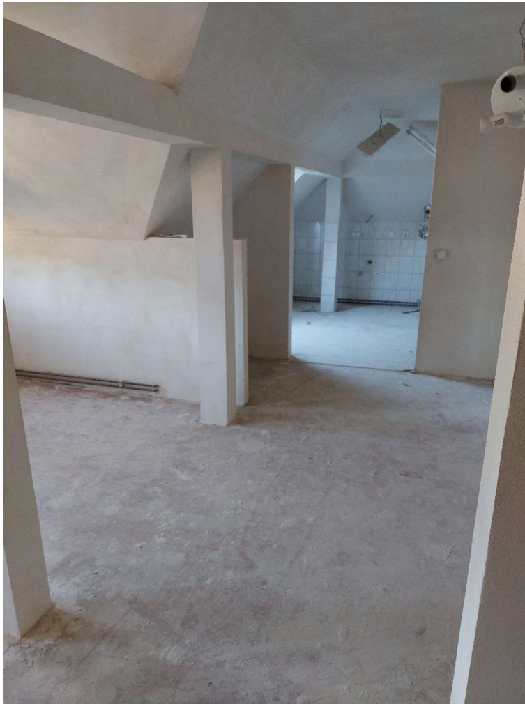
Obr. 3: Podkroví s prvky krovu opláštěnými sádrokartonem
